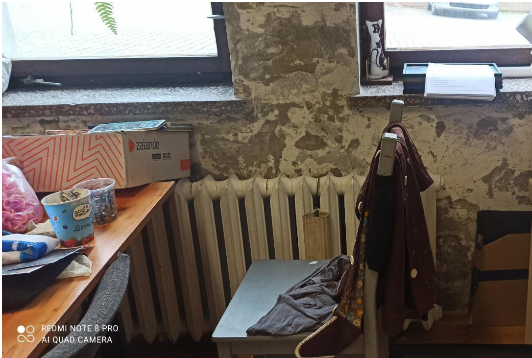
Widok pomieszczenia od środka
